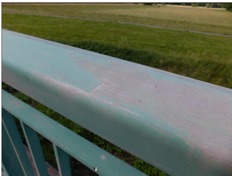
Detail ochranného nátěru zábradlí
