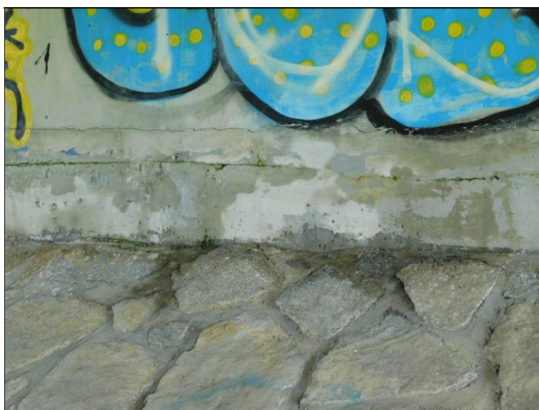
Trhlina ve vodorovné pracovní spáře dříku opěry 1
