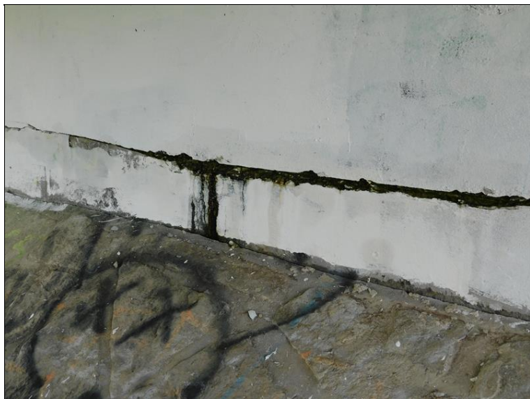
Trhlina ve vodorovné pracovní spáře opěry 8
