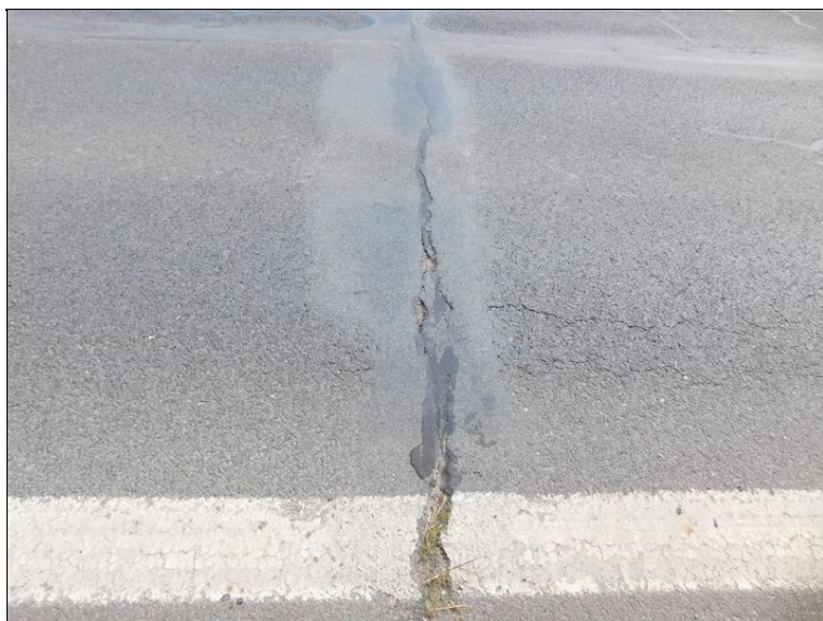
Trhliny ve vozovce v místě mostního závěru
