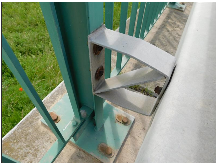
Spojovací a kotevní materiál zábradelního svodidla
